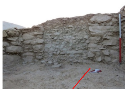
۱. دیوار ضلع جنوب شرقی فضای ۱؛ ورودی مسدود شده
